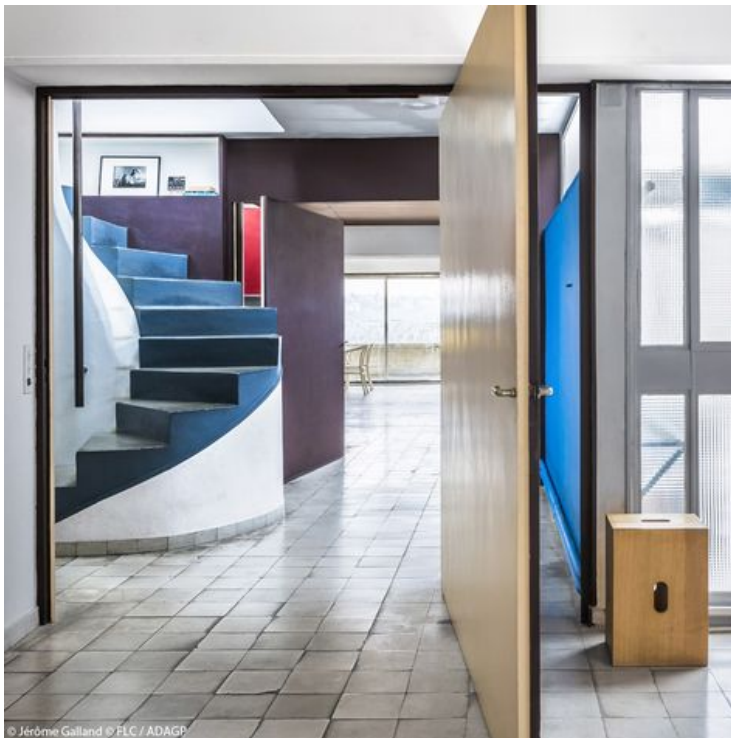
Figure 27 Système de portes pivotantes de l'entrée Photo : Jérôme Galland © FLC/ADAGP
