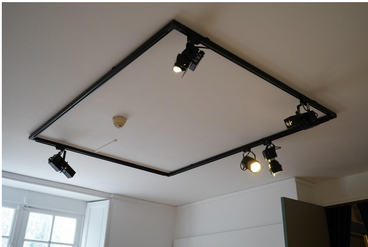
Photo. MDMD n°42 : Salle 3 – Plafond
