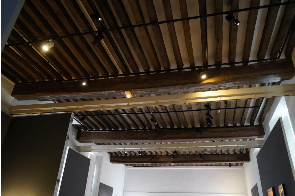
Photo. MDMD n°24 : Salle 1 – Plafond
