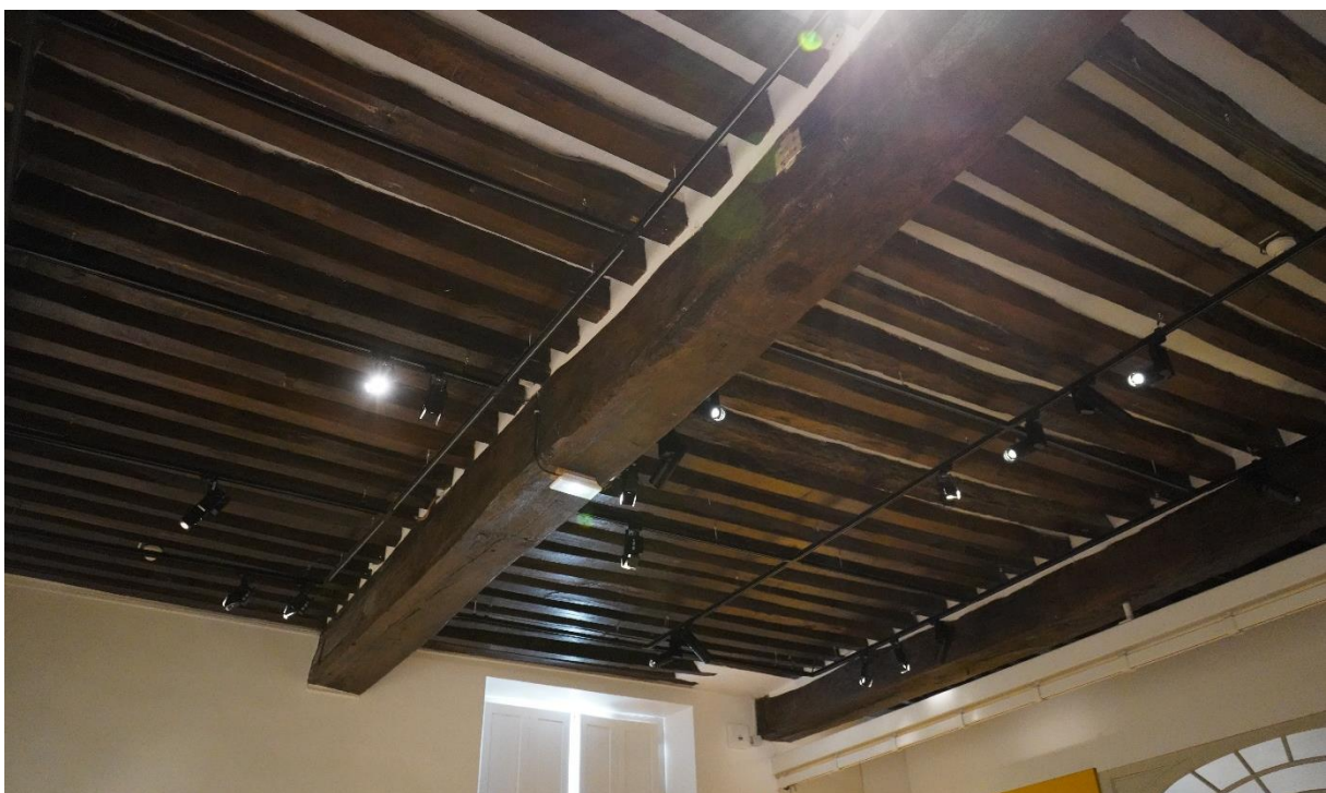
Photo. MDMD n°52 : Salle 4 – Plafond
