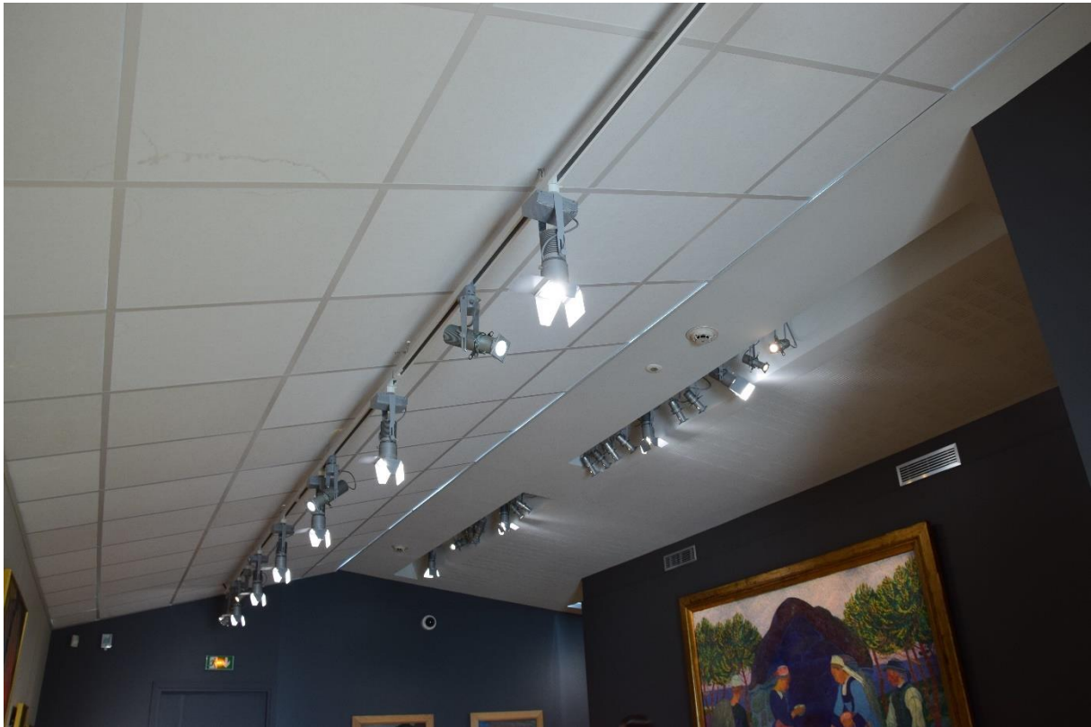
Photo. MPA n°77 : Salle 15 – Plafond
