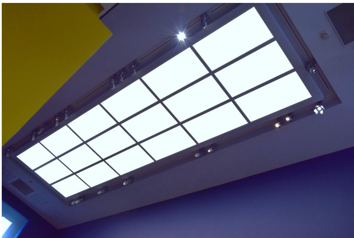
Photo. MPA n°50 : Salle 11 – Plafond
