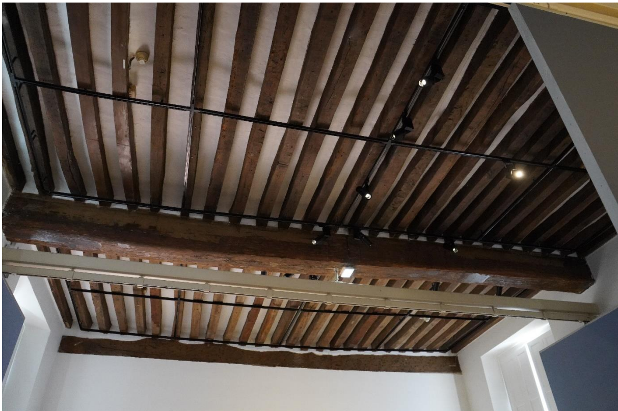
Photo. MDMD n°36 : Salle 2 – Plafond
