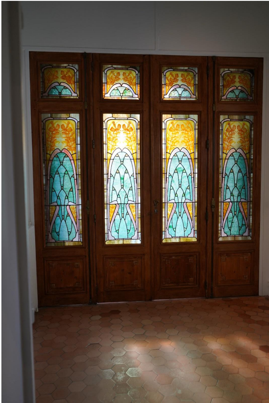
Photo. MDMD n°64 : Salle 6 – Mur Ouest
